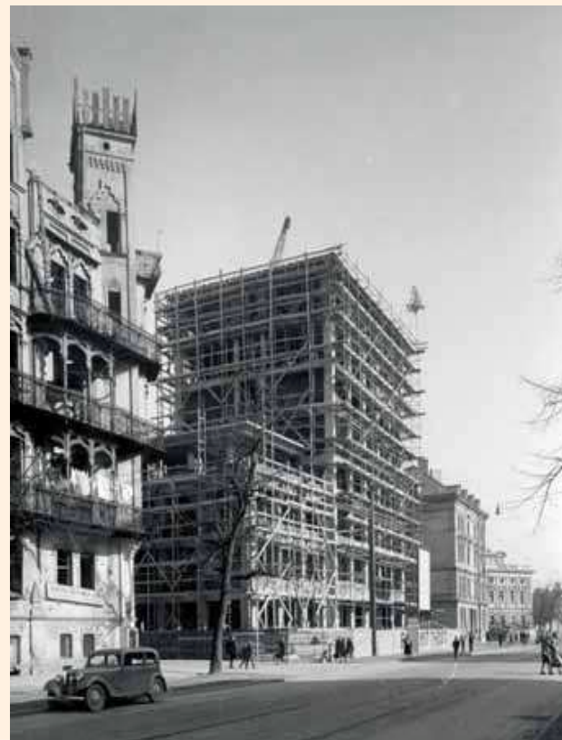
Fassade der Textilberufsgenossenschaft während der Erbauung
