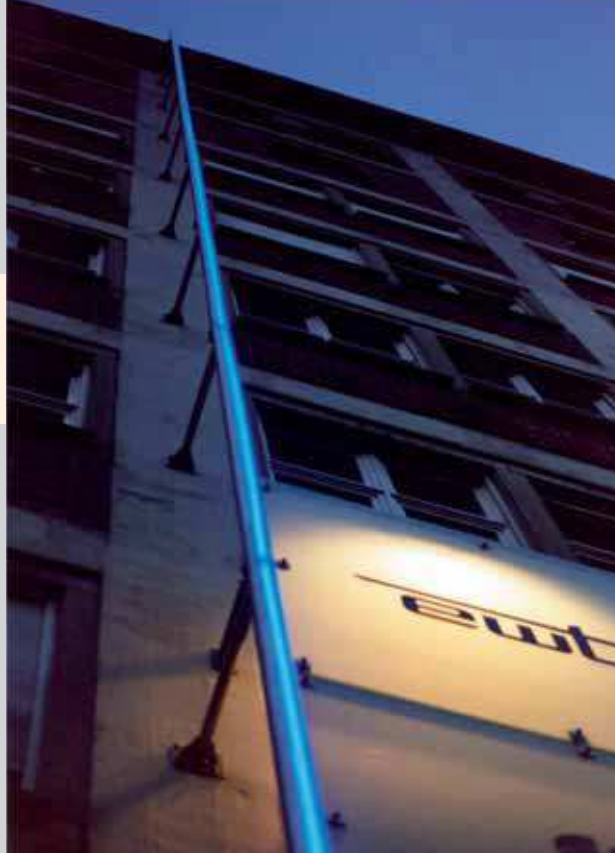
Die Außenbeleuchtung nimmt das Raster der Fassade auf
