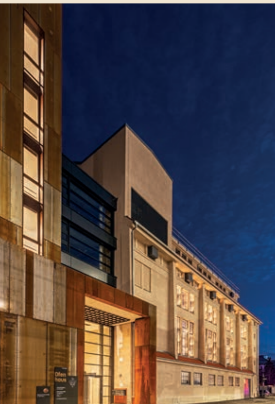
DIE AUSSENFASSADE mit Eingang – ein Industriedenkmal
