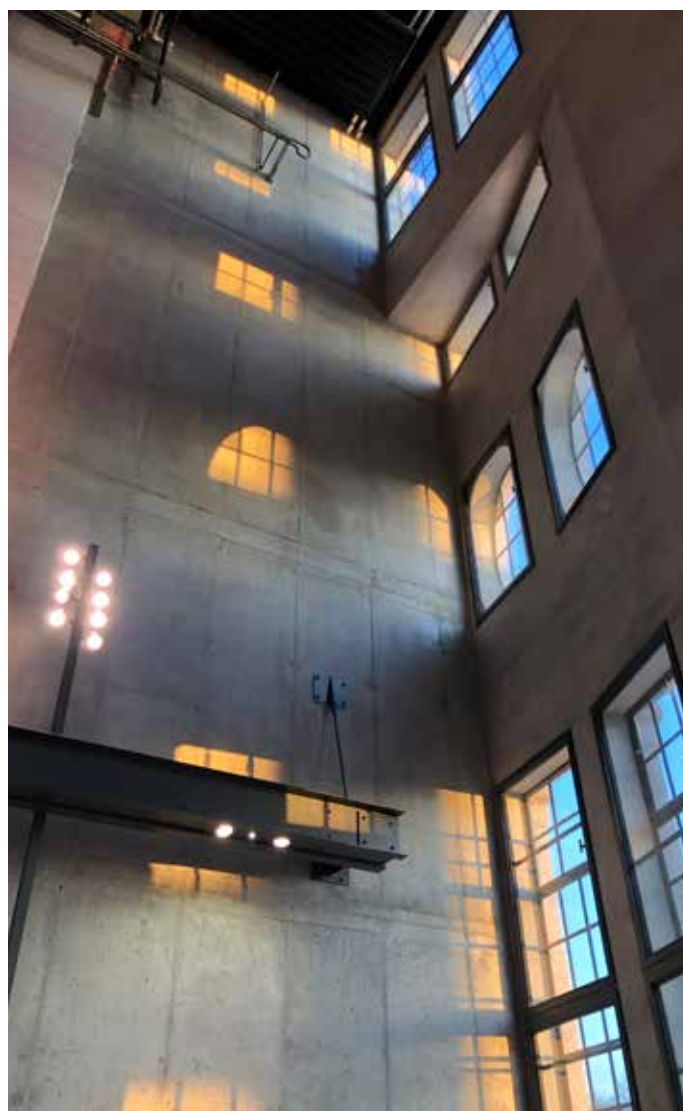
Abb.: Der vollständig entkernte Hauptraum mit einer Raumhöhe von etwa 19 m hat fast schon eine sakrale Anmutung. Durch die Industrieglasfenster ergeben sich ab der Nachmittagsstunde wunderschöne Lichtspiele. In der als Kranbahn-Laufschiene ausgeformten Stahlkonstruktion konnten die Strahler für die Beleuchtung zukünftiger Ausstellungen verbaut werden. Foto: Korona Leuchten
