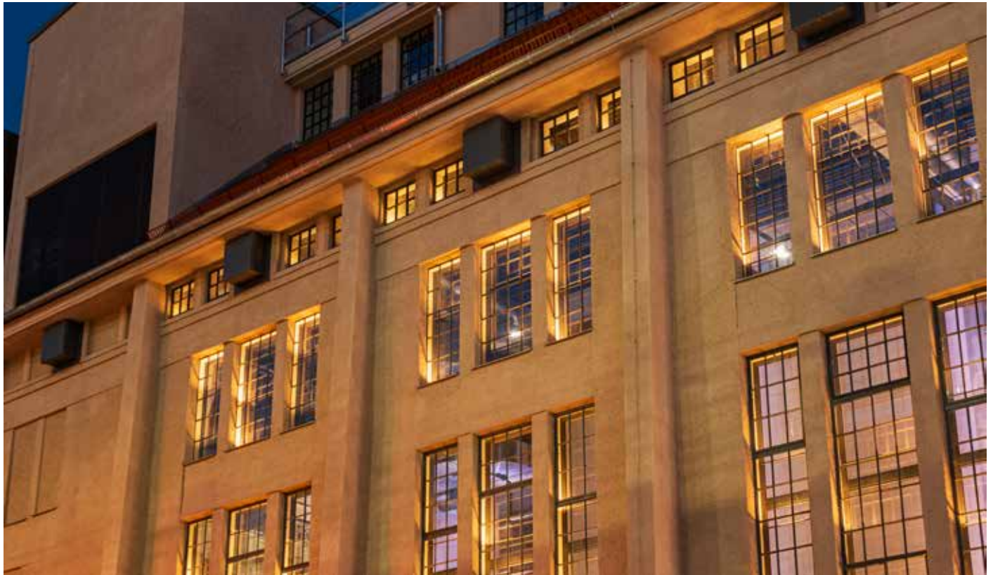
Abb.: Nachts wirken die Fenster wie von Kerzenschein beleuchtet. Hinter den alten Stahlrahmenfenstern wurde im Zwischenraum zu den neuen Isolierglasscheiben eine für jedes Fenster individuelle LED-Linienstruktur angebracht. Foto: Eckhart Matthäus Fotografie
